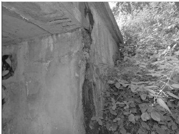
Degradace betonu, zamáčení, výluhy a celkový rozpad levého horního rohu OP1
