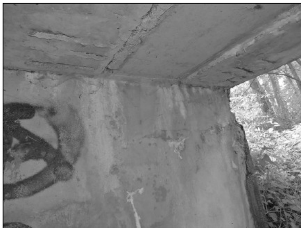
Zatékání v místě uložení s inkrustací a výluhy - levá strana OP1
