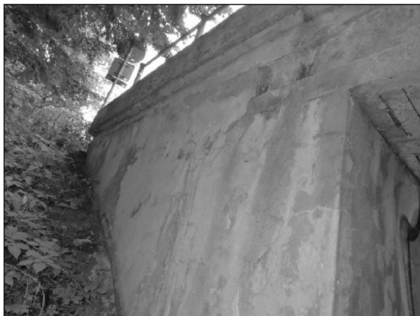
Trhliny, výluhy, inkrustace - křídlo č. 1, pravá strana
