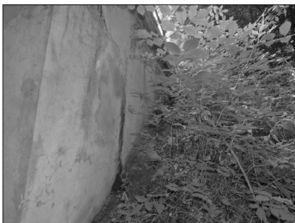
Trhlina, zavlhání, inkrustace - křídlo č. 2, pravá strana
